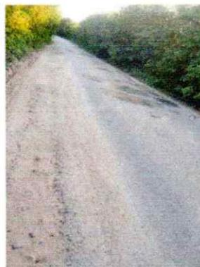
Foto tirada da RN177 por um de nossos associados que demonstra claramente a falta de acostamento, sinalização e muitos buracos.
